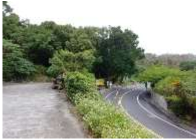
震宇基地南端現況平台
