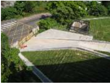
震宇北端冷水儲水場
