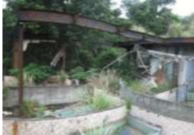
現況巴登廢棄設施
